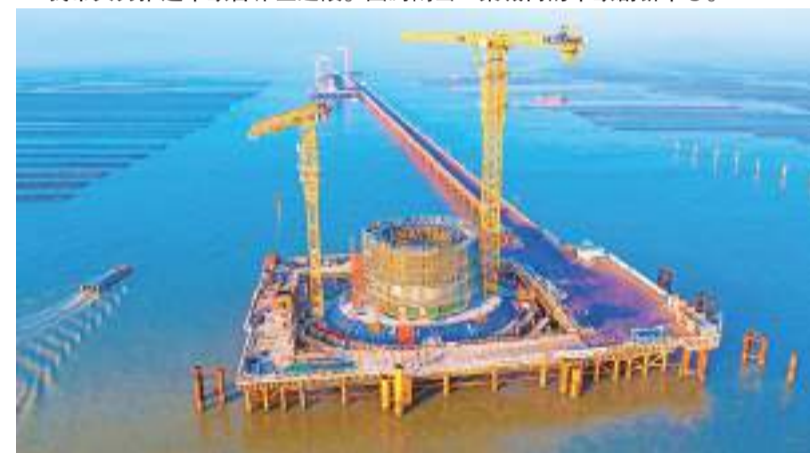
黃茅海跨海通道主橋之一的黃茅海大橋逐漸“長”出海面。
