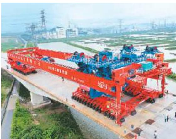
世界最大吨位1800吨级整孔预制箱梁架桥机“越海号”。中铁科工供图
