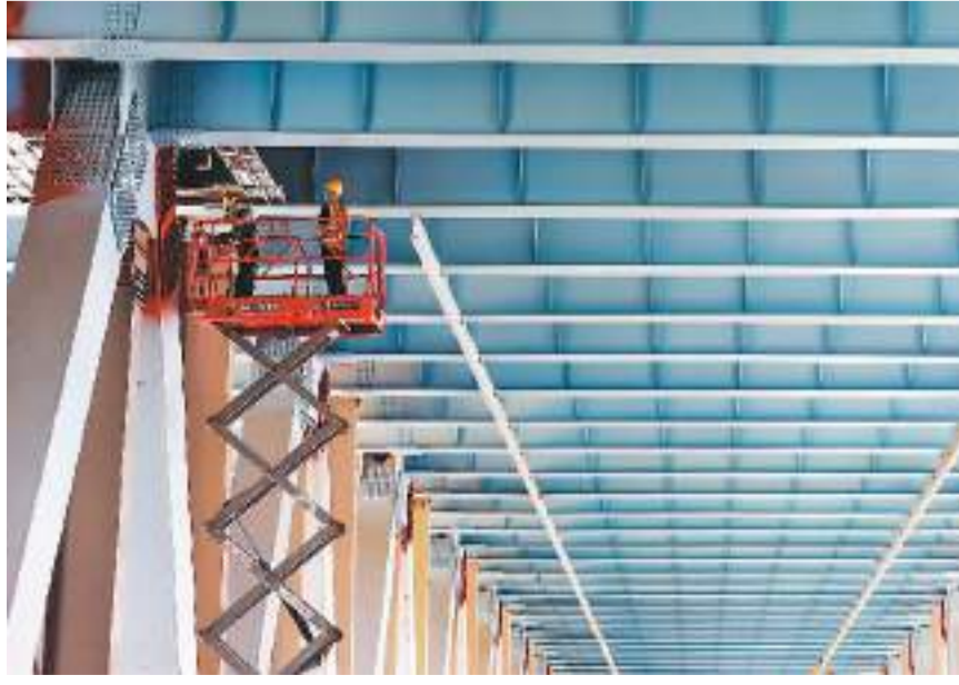
7月12日，在重庆郭家沱长江大桥下桥面施工现场，施工人员进行螺栓紧固作业。新华社记者 刘 潺摄
