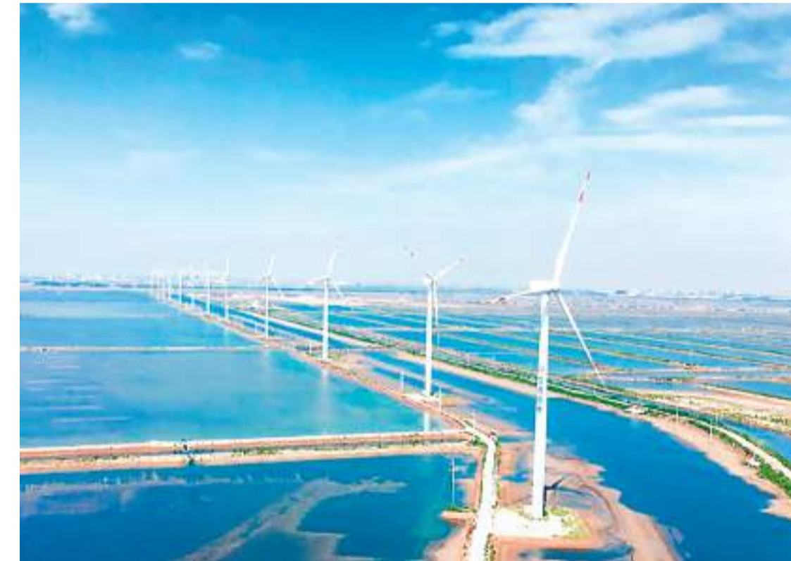
▲中国人寿集团旗下资产管理公司发起设立的“中国人寿—中核1号股权投资计划”近日顺利完成募集发行，20.53亿元战略增资中核汇能有限公司，主要用于光伏、风电等新能源发电项目开发、建设等。图为中核潍坊风电项目。
