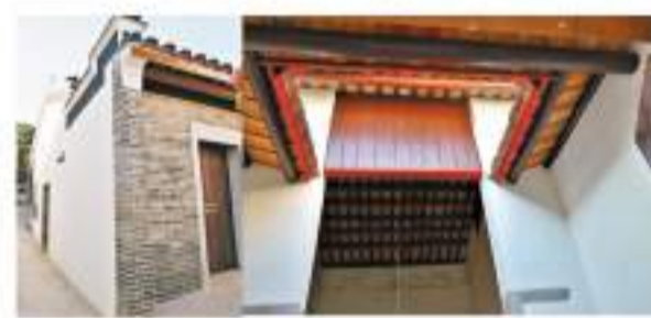
◆修葺好的村屋，可作日後民衆之用。
