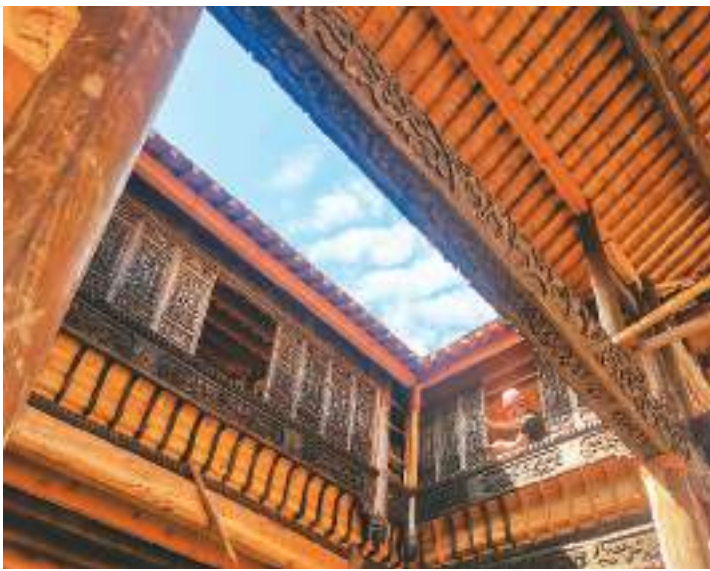
湖北省孝感市云梦县在吴铺镇集中归类复原一批特色古建筑，让文化与城市融合发展，传承好古建筑文化艺术。图为近日，在吴铺镇云梦古建筑修复工地，工匠正在作业。 胡学军摄（人民视觉）
