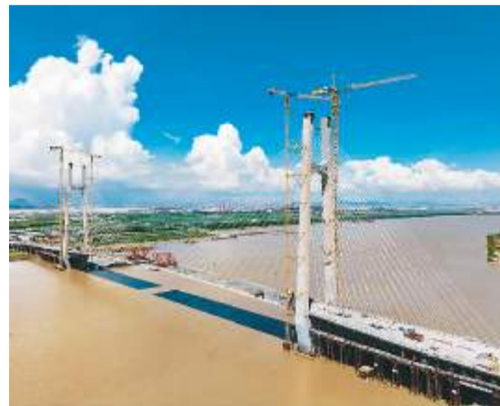
近日在广东省广州市南沙区的红莲大桥建设现场，工程建设者正在抓紧作业，推进各环节工程建设提速。作为南沙的重点交通基础设施项目，大桥建成后主要承担广州南沙自贸区万顷沙保税港加工制造业区块与南沙港的货运交通联系。图为建设现场。魏劲松摄（人民视觉）
