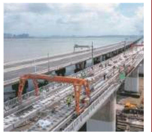
泉州灣跨海大橋無砟軌道施工現場
