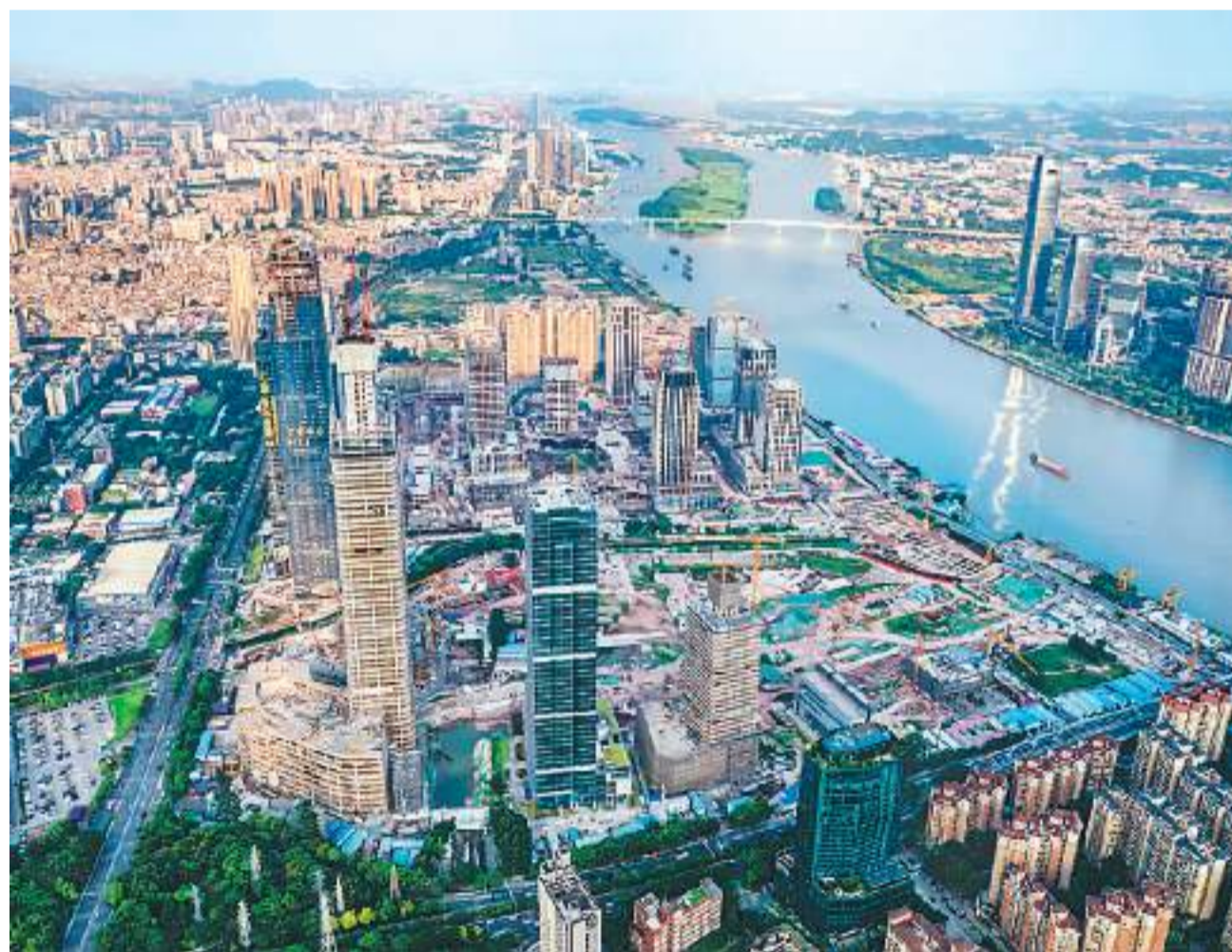
近日，位于广东省广州市天河区广州国际金融城施工现场塔吊林立，建设如火如荼。“十四五”时期，广州国际金融城将聚力发展供应链金融、科技金融、数字金融、绿色金融、跨境理财资管等特色金融，支撑广州加快打造粤港澳大湾区国际金融中心引擎。图为广州国际金融城。
