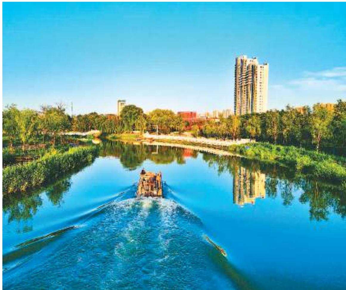
7月21日，京杭大运河沧州段代家园码头由中铁二十二局集团铺装完成。至此，京杭大运河沧州段生态廊道11个码头全部建成，为大运河沧州城区段恢复通航奠定了基础。
