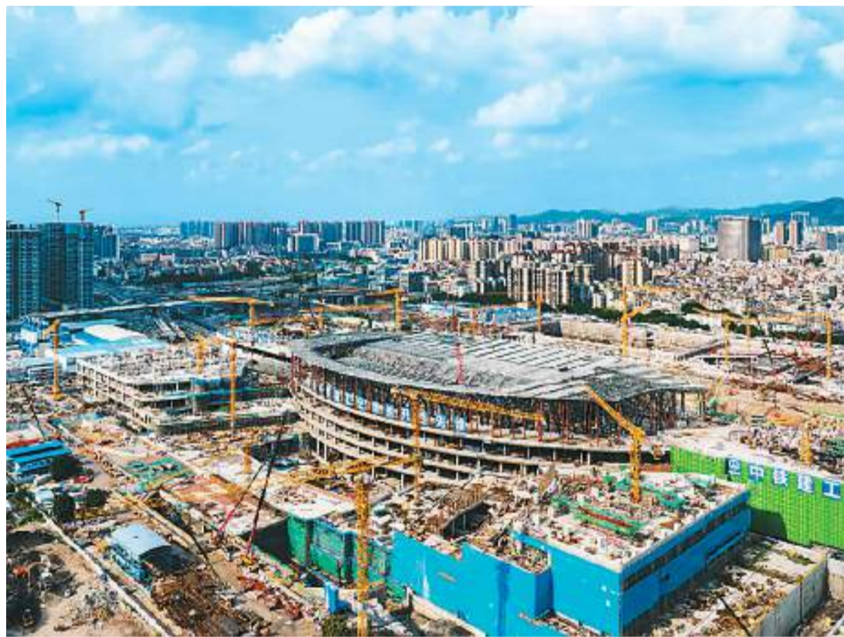
近日，广东广州白云火车站建设现场如火如荼，工人们正加紧施工。广州白云火车站是粤港澳大湾区的重点工程，该项目建成将成为具有岭南特色的大型综合交通枢纽。 图为建设中的广州白云火车站。 魏劲松摄（人民视觉）
