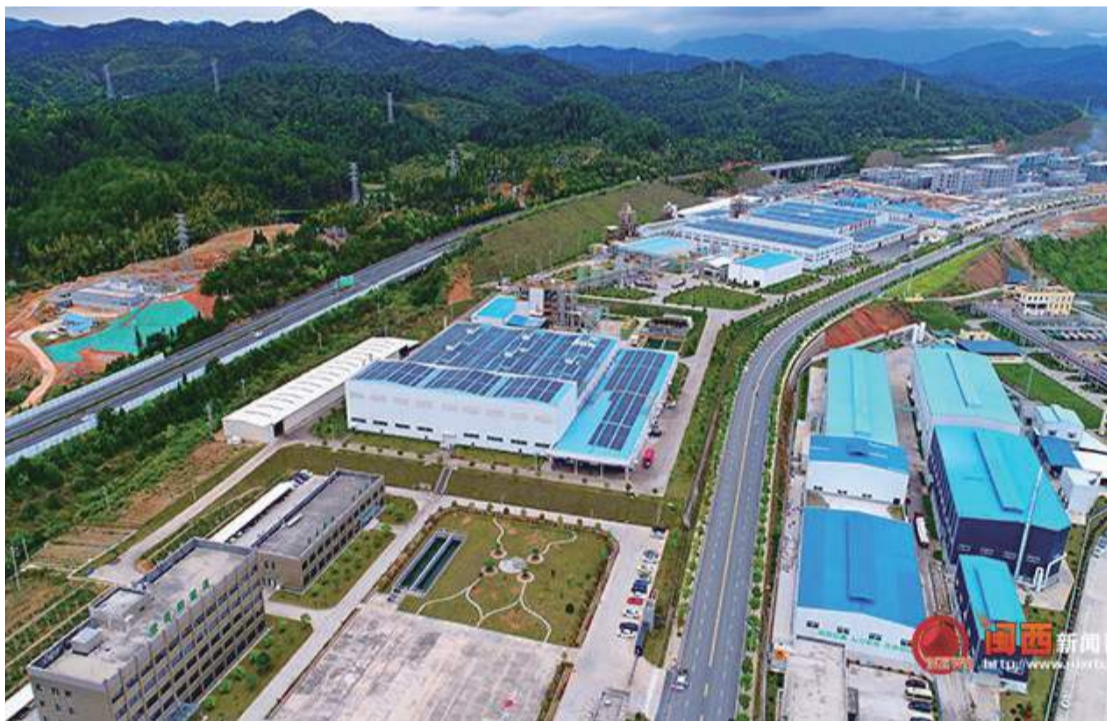
上杭蛟洋工業園區一角
