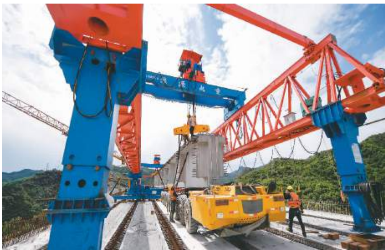
8月23日，首都地区环线高速公路河北承德至北京平谷段工程建设有序推进，工人们在现场加紧施工。工程主线全长59.176公里，采用双向六车道，设计时速80公里，预计2024年建成通车，建成后将对完善京津冀区域路网、推进京津冀交通一体化、促进沿线经济和旅游业快速发展具有重要意义。图为工人在架设T梁。 王立群摄（新华社发）
