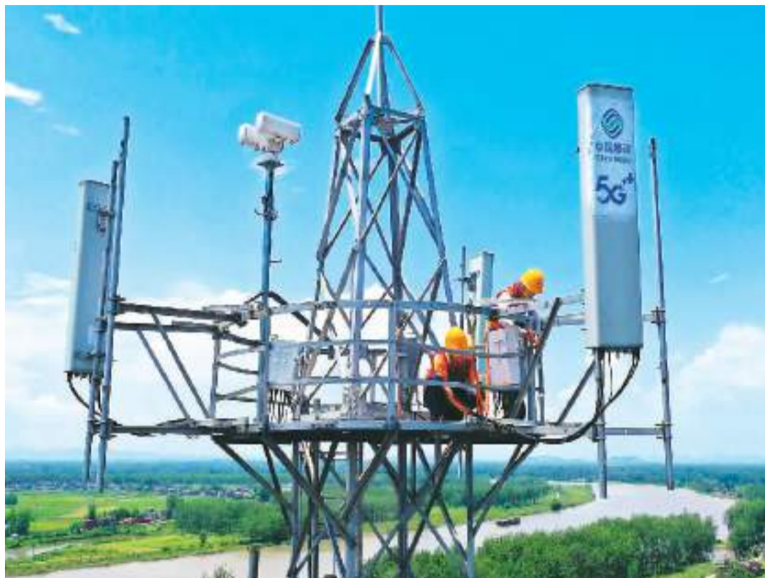
安徽移动铜陵分公司工作人员在铜陵市义安区胥坝乡5G基站铁塔上调试天线。
