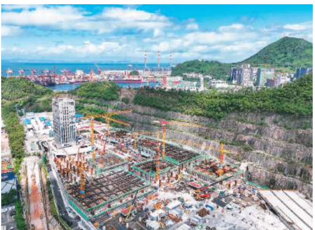
近日，位于广东深圳蛇口的地铁12号线赤湾停车场主体工程全部完工，将于年底投入运营。据介绍，该工程是深圳目前在建规模最大的地铁停车场，建成后承担地铁12号线部分列车的停放、列检等工作。图为深圳地铁12号线赤湾停车场建设现场。 王美燕摄(人民视觉)
