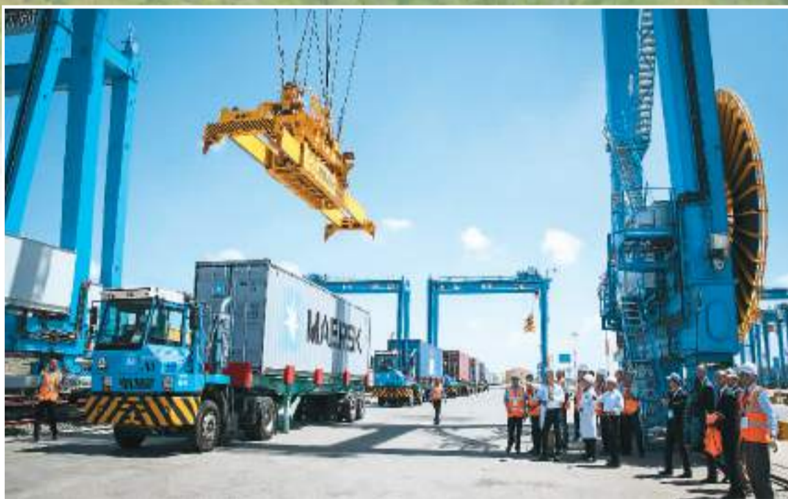
▲ 过去5年,蒙内铁路累计运送集装箱177.3万标箱,目前日均开行16列货运列车,促进了肯尼亚本国以及与其他东非国家的经贸往来。因为肯尼亚铁路项目重要配套工程内罗毕内陆集装箱港一派繁忙。 新华社记者 吕帅摄
