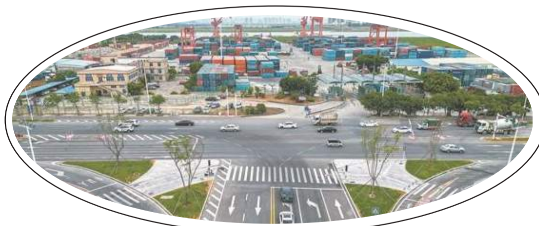
改造提升後的豐海路—海星街交叉口
