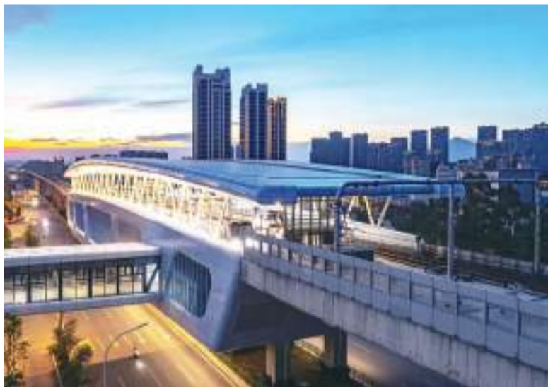
地铁6号线营前站,是6号线唯一,也是福州地铁首个高架站。
