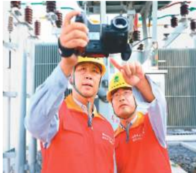
日前，国网安徽省电力有限公司濉溪县供电公司员工利用5G通信、智能巡检机器人，对安徽省首个“5G+源网荷储”新一代变电站示范工程——35千伏谭家变电站设备进行调试和巡检。谭家变电站工程投运后，将提高濉溪电网迎峰度夏能力，助力当地经济社会发展。
