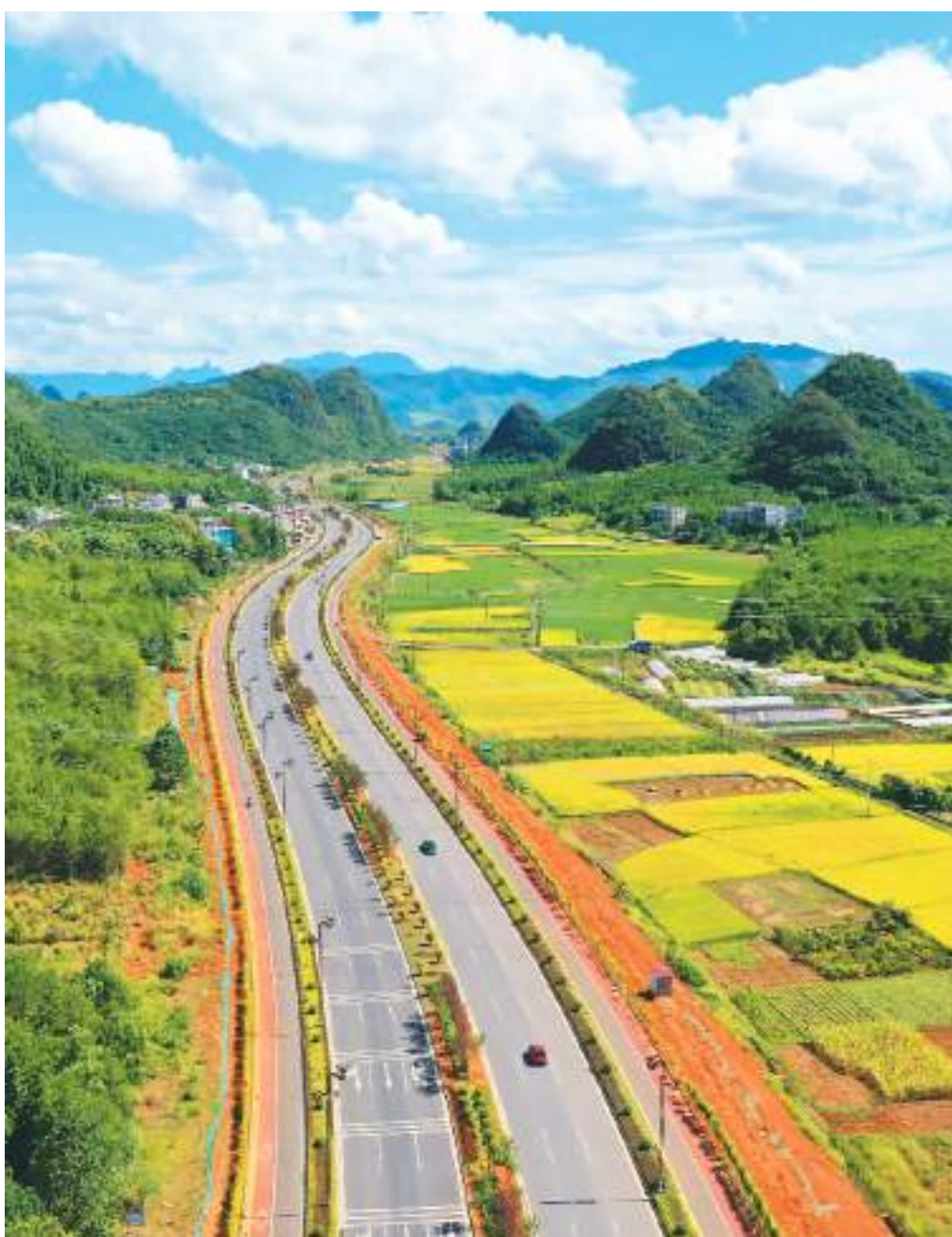
近年来,湖南省永州市宁远县大力实施交通先行工程,以“建好、管好、护好、运营好”农村“四好公路”为目标,加大建设投入,完善管养机制,推动城乡客运公交一体化,助力乡村振兴。目前,全县农村公路总里程达2632.01公里,建制村通畅率达到100%,形成了四通八达的路网。图为车辆行驶在通往宁远县九嶷山瑶族乡的公路上。何红福摄(人民图片)
