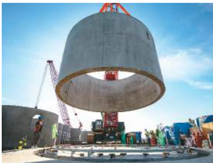
日前，安徽省亳州市谯城区160米风力发电机组混塔开始吊装。该项目共计20台，每台装机容量5兆瓦，建成后将助力改善生态环境，减少碳排放，推动地方经济发展。图为在谯城区双沟镇周大村，施工人员吊装风力发电机组混塔。 梁西海摄（人民视觉）
