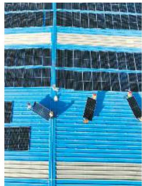
6月30日，湖北省十堰市房县北城工业园区厂房屋顶，施工人员在安装太阳能电池板。
