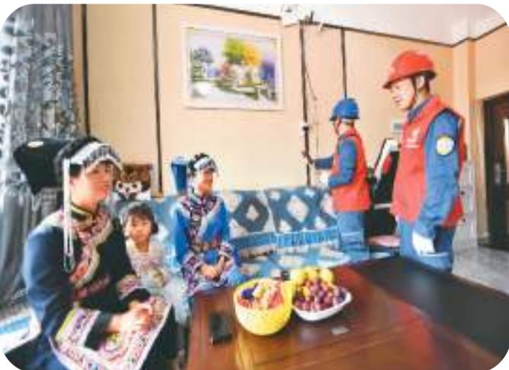
为解决群众用电方面难题，南方电网去年底在贵州省六盘水市水城区海坪村建设“南网驿站”，打通服务群众用电“最后一公里”。图为日前，“南网驿站”的六盘水供电局工作人员在海坪村易地扶贫搬迁点索玛社区为彝族群众检查用电安全。李 丞摄
