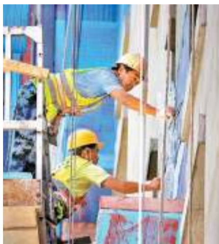
◆兩名工人正在住宅工地工作。資料圖片
