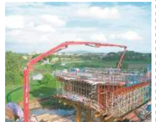
混凝土源源不斷向銀洲湖高速公路首個0號塊澆築。
