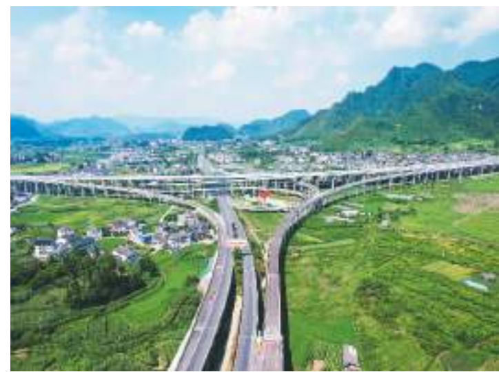
日前, 位于贵州省遵义市的兰海高速重遵扩容工程蒲场特大桥竣工。蒲场特大桥位于重遵扩容高速公路蒲场枢纽互通与绥遵高速十字枢纽交叉处, 是兰海高速重遵扩容项目14标段控制性工程, 全长1.61公里。图为蒲场特大桥。 罗星汉摄(人民视觉)
