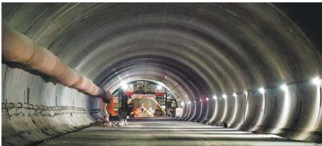
8月8日17時，獅山隧道左右線貫通。圖為獅山隧道內部。 郭永樂 攝
