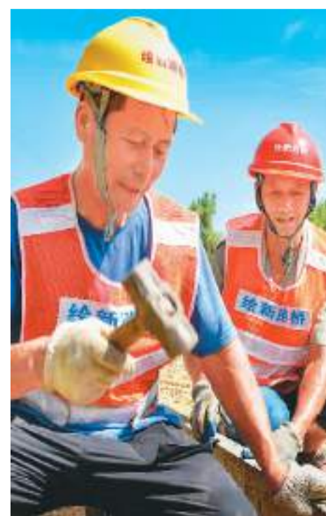
湖北省蕲春县马崇线施工现场，农村公路建设者正在忙碌。
