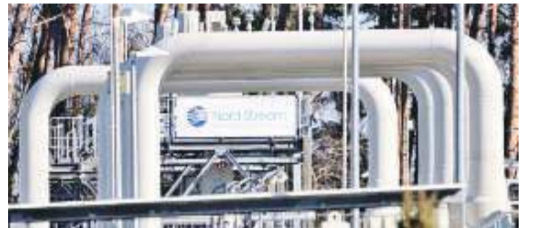
资料图：“北溪-1”天然气管道。
