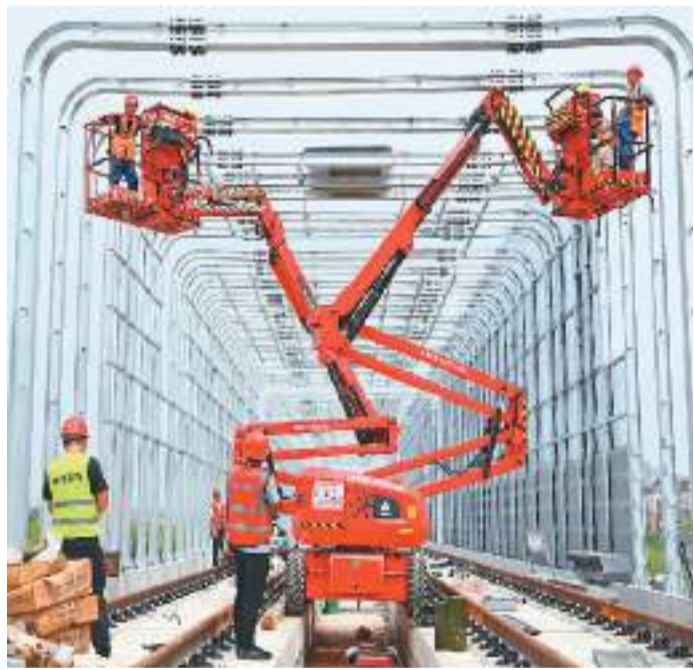
中秋假期，铁路建设者坚守岗位，推进建设，确保进度。图为在安徽省滁州市南谯区腰铺镇，建设者在滁（滁州）宁（南京）城际铁路二期高架线上安装环保声屏障。宋卫星摄（人民视觉）
