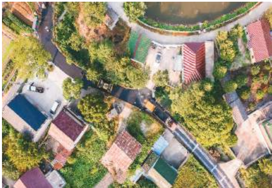
安徽省芜湖市近年来多措并举推进农村道路建设,为乡村振兴提供便利的交通条件,有效带动农村经济发展。图为在进行沥青路面浇筑作业。肖本祥摄(人民视觉)
