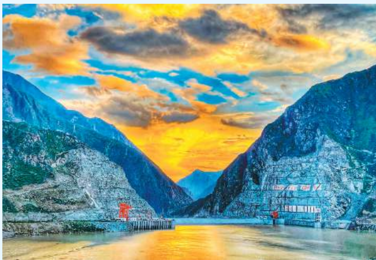
图为坐落于西藏自治区芒康县与四川省巴塘县交界的苏洼龙水电站。
