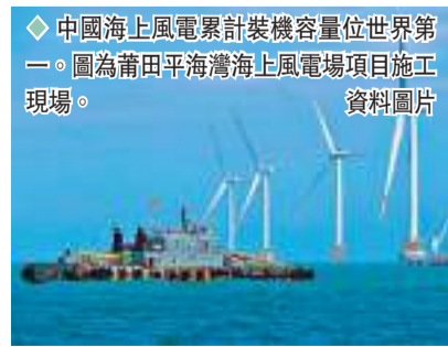
◆中國海上風電累計裝機容量位世界第一。圖為莆田平海灣海上風電場項目施工現場。
