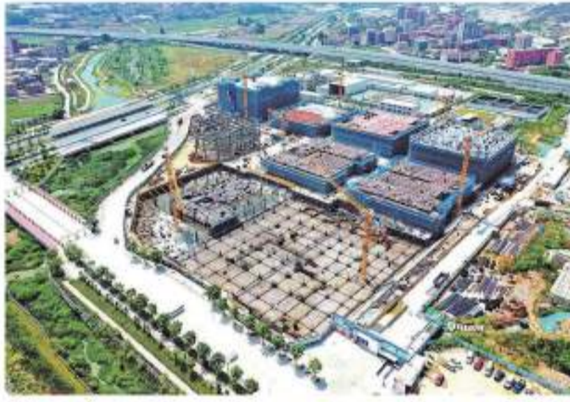
位於南安市石井鎮的泉州芯谷南安科創中心項目施工現場,一輛輛施工車往來穿梭,一個個施工人員揮汗如雨,推進着
