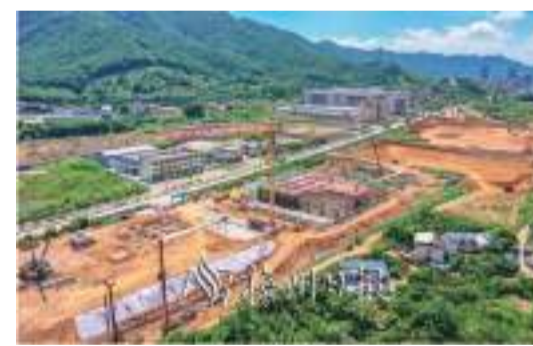
施工方正積極推進產業園主體結構建設。（吳騰江攝）
