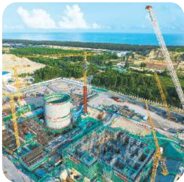
位于海南昌江的玲龙一号建设工地。
