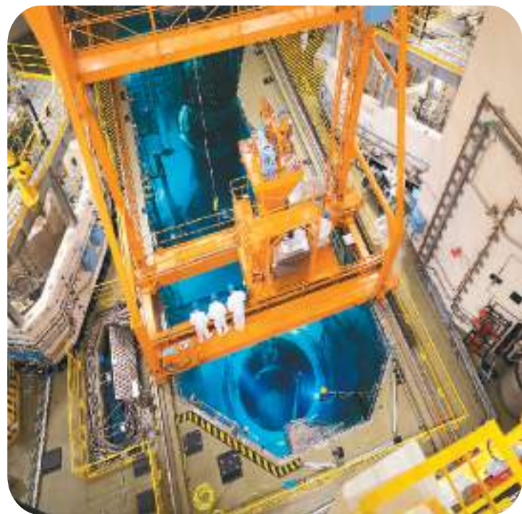
华龙一号福清核电6号机组装料水池。
