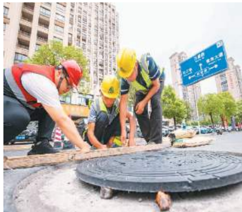
江苏省海安市城建集团的工人正在城区安平路安装新窨井盖。
