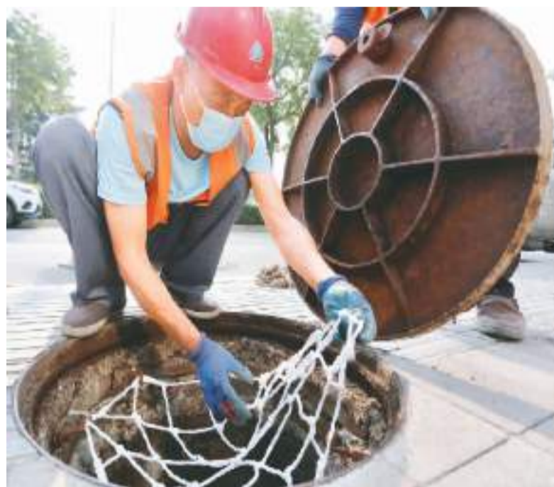
在山东省泰安市，施工工人正在为窨井加装安全防坠网。
