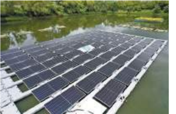
新田鄉村防洪計劃的蓄洪池成首個浮式太陽能發電系統試點。
