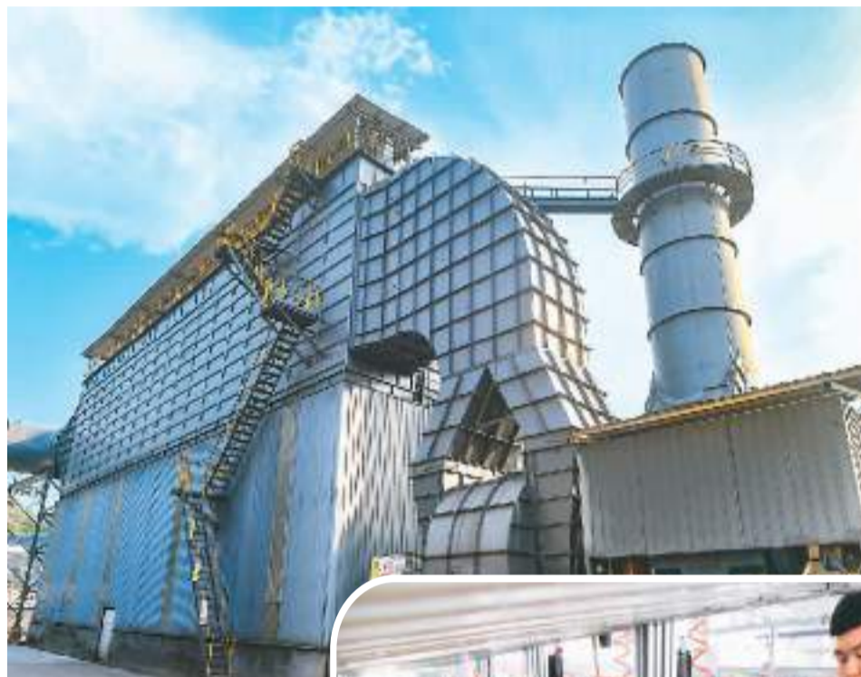
▲国家级专精特新“小巨人”企业——安徽富凯特材有限公司聚焦低碳减排，冶炼的特种金属材料中，主要污染物排放浓度远低于钢铁企业超低排放的国家标准。图为该公司的电炉除尘设备。袁兵摄（人民视觉）
