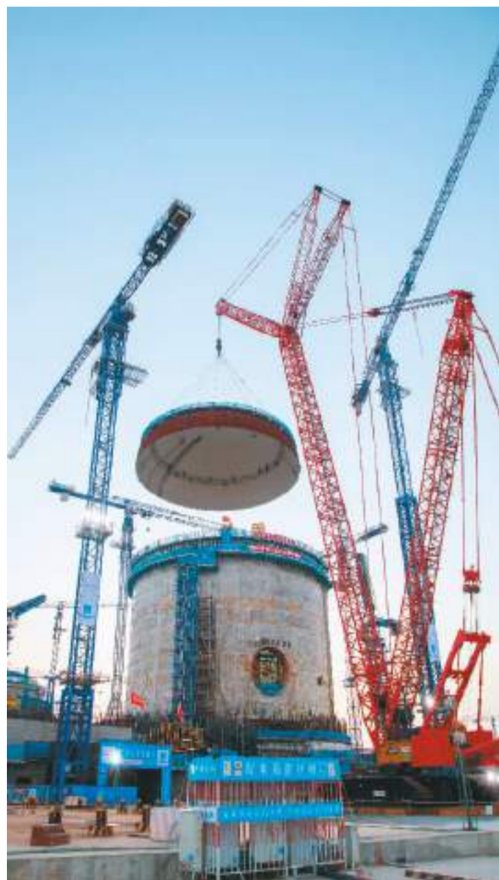
9月25日，广东省惠州市，中广核广东太平岭核电项目华龙一号2号机组核岛穹顶吊装。黄辉延摄
