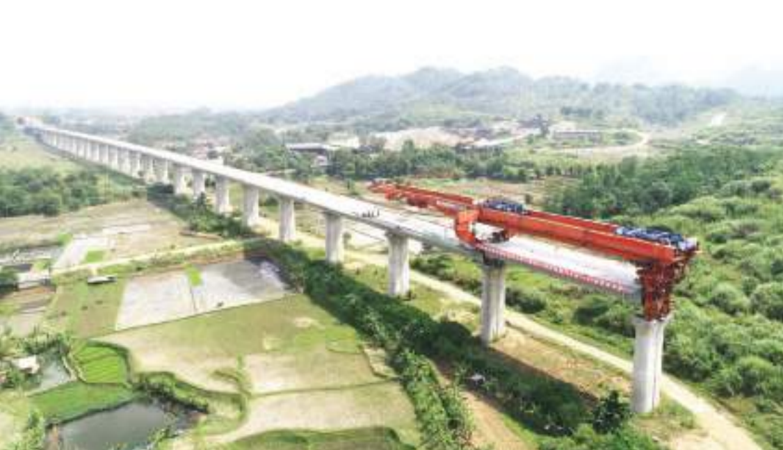
9月7日在西爪哇省拍摄的雅万高铁4号梁场1066榀箱梁架设任务施工现场(无人机照片)。 新华社发(王增堃摄)
