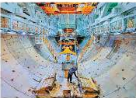
◆前海跨海通道作為國內在建最大水下盾構工程，施工過程中面臨諸多挑戰。圖為項目工作人員正在進行工作。受訪者供圖
