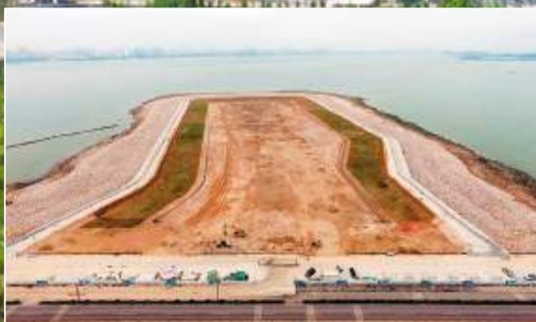
↑汕頭海灣隧道南岸圍堰主體完工
