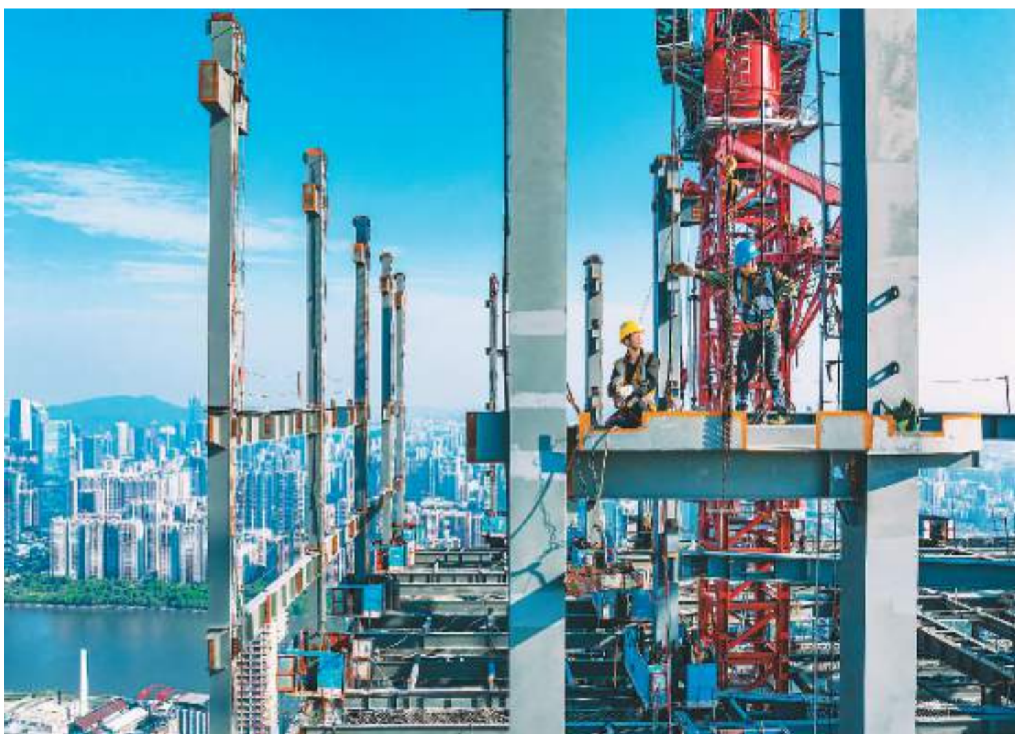
广东广州琶洲人工智能与数字经济试验区吊塔林立,座座高楼正拔地而起,建设者在高空开展各项作业,现场忙碌有序。
