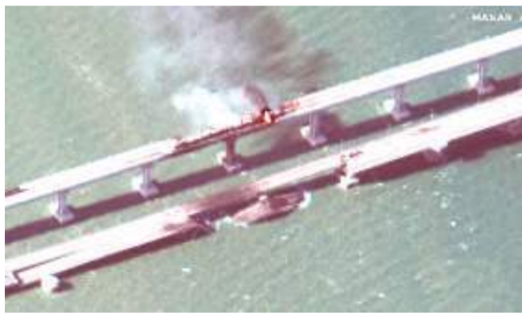
当地时间10月8日,卫星航拍爆炸起火的克里米亚大桥,桥面上浓烟滚滚,部分路面断裂。
