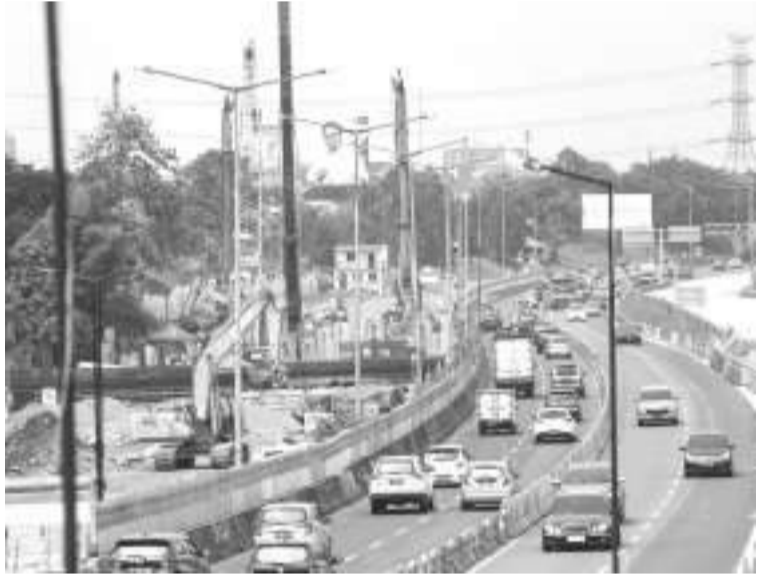
本托阿连-瑟榜高速公路防洪项目 为应对本托阿连 (Pondok Aren) - 瑟榜 (Serpong) 高速公路经常遭水淹，公共工程及民居部将建20米宽的桥梁取代原先的箱涵，按计划在2023年5月竣工。
