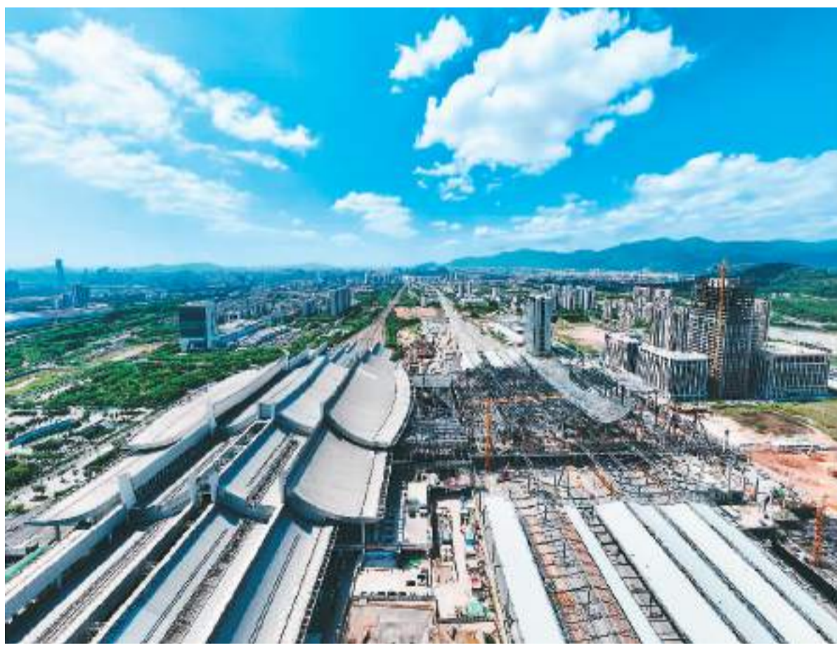
中国首条跨海高铁——新建福州（门）铁路不久前全线铺轨贯通，目前铁路沿线站房等工程正加紧建设。新建福州铁路设计时速350公里，正线全长277.42公里，建有湄洲湾、泉州湾、安海湾3座跨海大桥，全线共设厦门北站、福州南站等8座车站。铁路建成通车后，福州、厦门两地将实现“一小时生活圈”，厦门、泉州、漳州闽南“金三角”将形成半小时交通圈。图为10月9日拍摄的由中铁建设承建的厦门北站主站房钢结构施工现场。 武冲摄（人民视觉）
