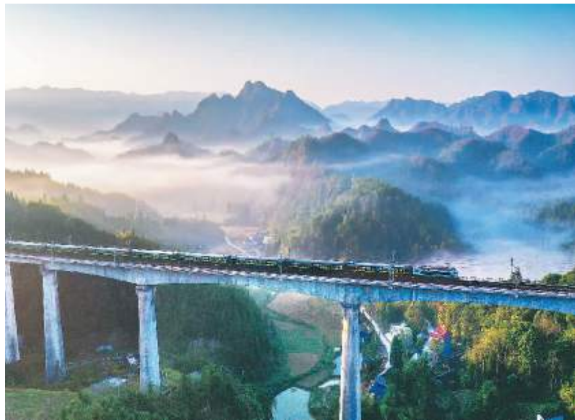
近年来,黔张常(重庆市黔江区—湖南省张家界市—湖南省常德市)铁路的开通运行打破了制约武陵山片区的发展瓶颈,乡村振兴驶上快车道,沿线经济发展有了腾飞的翅膀。图为9月29日,列车飞驰在黔张常铁路湖南省龙山县红岩溪镇西湖冲特大桥上。
