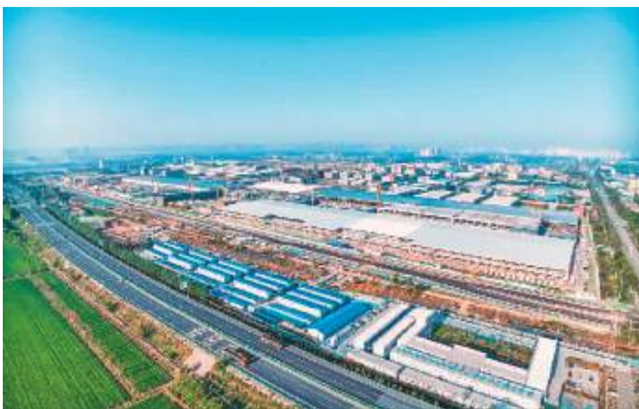
9月28日,在陕西省西咸新区泾河新城,由中建八局西北公司承建的隆基绿能年产15GW高效单晶电池项目一号车间正式投产。该项目是隆基绿能科技股份有限公司目前单体最大、产能最高的光伏电池生产基地,其量产后的电池转换效率、单片加工成本将达到业界领先水平。预计2023年该项目产能满产后,每天可生产电池片1000万片,年产值约300亿元。图为该项目外景。 王 欣摄(人民视觉)
