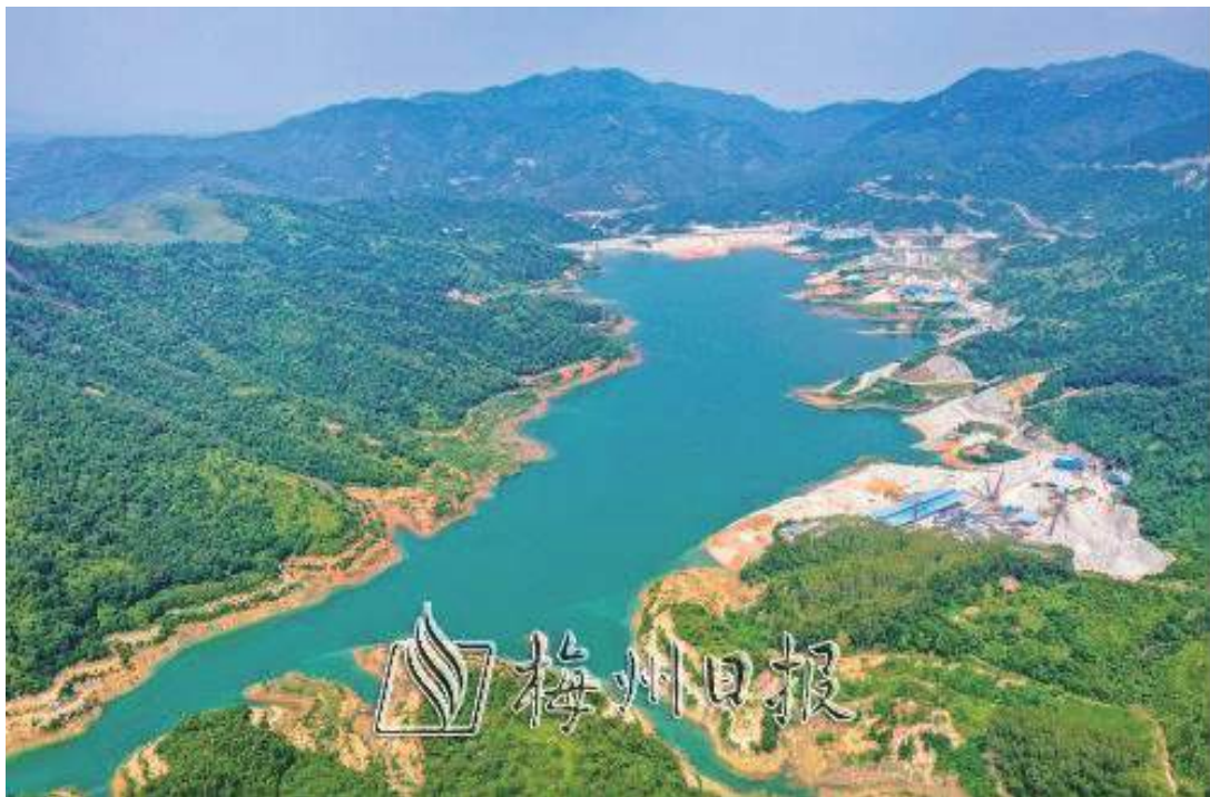
梅州(五華)抽水蓄能電站坐落於群峰之間,是廣東省首個核准批復的抽水蓄能電站項目、梅州歷史上單體投資最大的基建工程。(吳騰江 攝)
