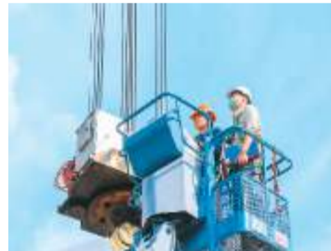
图为近日在泰国呵叻，中泰铁路项目部监理四组组长威罗（右）在工作中。新华社/法新
