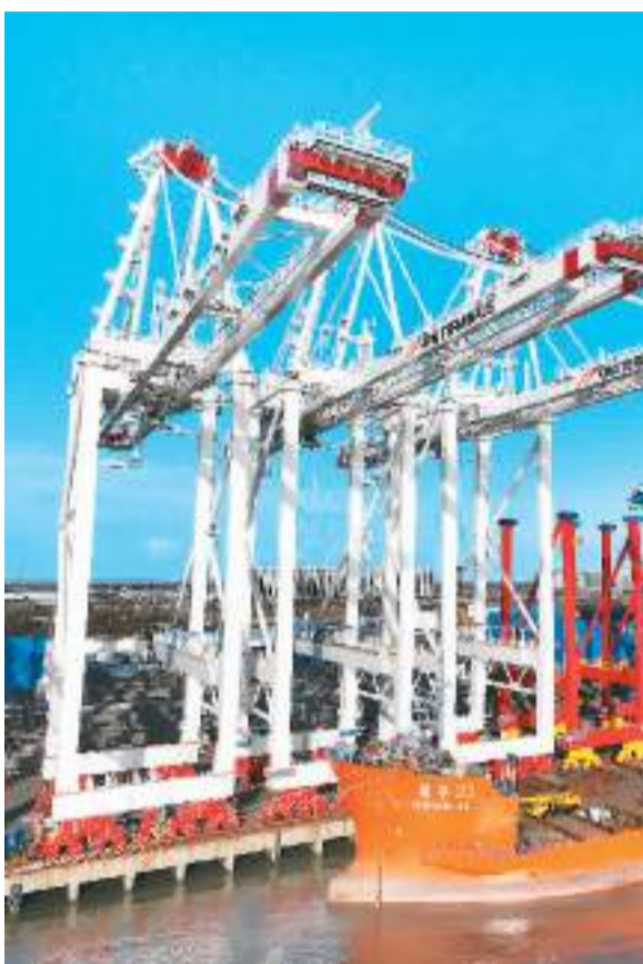
上海振华重工产品已进入一百多个国家和地区,承担全球约七成的自动化码头项目建设。图为十一月二十三日,在振华重工长兴分公司准备出口的岸桥设备。
