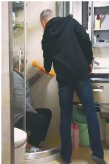
图为10月26日，浙江省杭州市余杭区79岁张季维老家的浴室里，正在安装扶手。 孔亚鲁摄（人民视觉）
