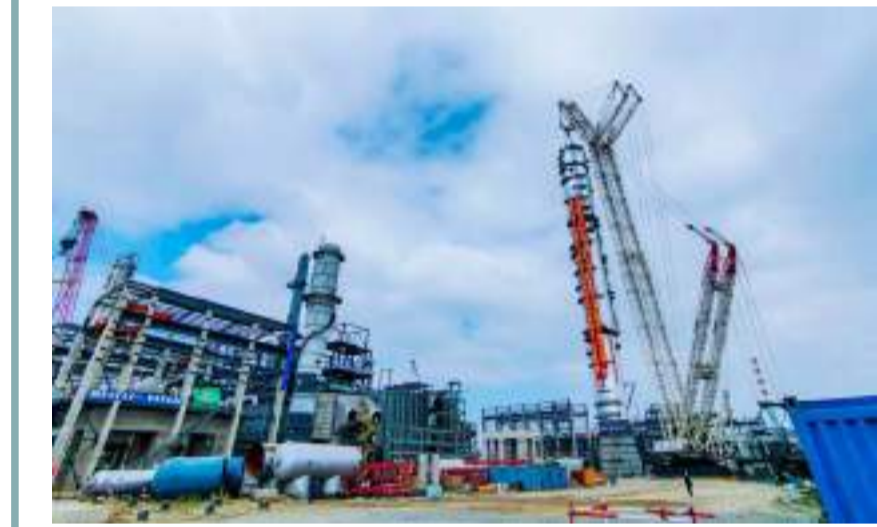
21日上午,全球最大丙烷丙烯分离塔在福清成功吊装。石美祥/图
