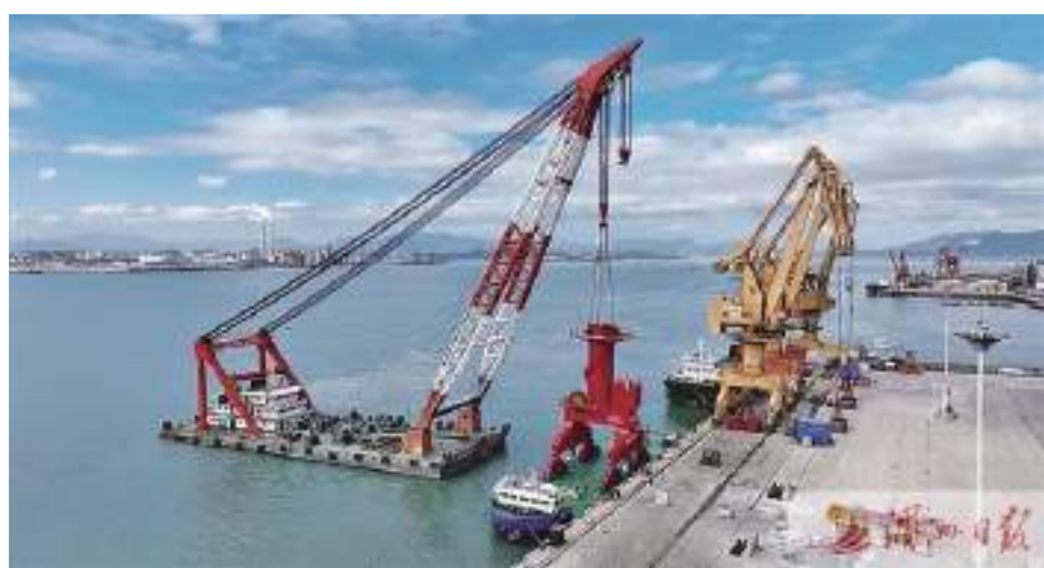
圖為在秀嶼作業區1#泊位安裝起重機。
