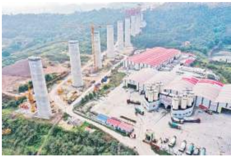
渝昆高铁川渝段建设稳步推进 这是11月28日拍摄的渝昆高铁川渝段站前一标2号拌和站及华福特大桥作业现场(无人机照片)。 日前,由中铁十一局承建的渝(重庆)昆(昆明)高铁川渝段站前一标项目正加紧施工,工程进度稳步推进。渝昆高铁全长699公里,设计时速350公里,是全国高铁网“八纵八横”之一京昆通道的重要组成部分。 新华社记者 王全超 摄
