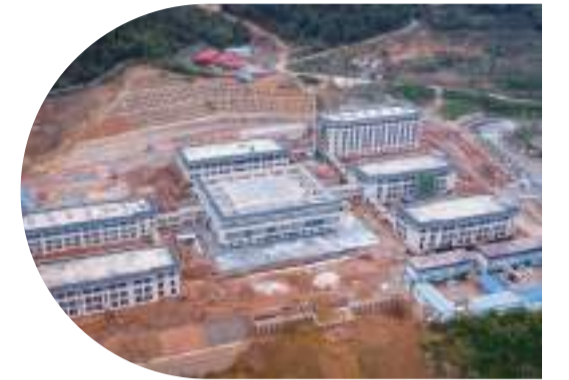
新羅能源互聯網繼續教育基地項目主體結構已完工，正進行樓房室內外裝修。項目預計今年年底竣工驗收。圖為近日拍攝的基地。通訊員 張銳暢 攝
