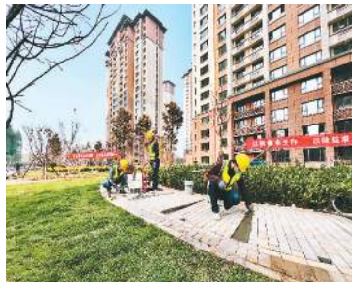
11月17日，中铁二十二局集团参建的河北省重点民生工程——保定市主城区城中村改造工程王七里店安置区项目一期项目落成。本次完工项目涉及土地约1.5万亩，11个安置区，共152栋安置房，惠及17个村，6000余户、2.4万人。整项工程分四期进行，新建安置区63个。图为建设者在小区内进行施工作业。李建军摄（人民视觉）
