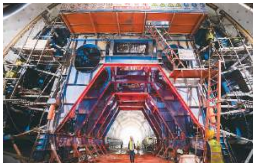
近日由中铁七局承建的新建沪渝蓉高铁武宜段7标罗家村隧道顺利贯通,成为全线首座贯通的隧道。据悉,新建沪渝蓉高铁是国家“八纵八横”高铁骨干通道之一,建成后东西横贯国内6个省份,串联起长三角城市群、长江中游城市群和成渝双城经济圈,对构建长江综合交通运输体系和推进长江经济带发展具有重大意义。图为建设现场。郭强摄
