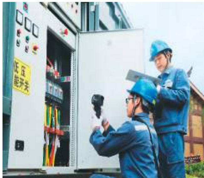
近日，南方电网贵州省铜仁市松桃苗族自治县供电公司110千伏等级以下变电站开展夜间巡视，全力保障迎峰度冬期间电网和设备安全稳定运行。图为工作人员正在巡视设备。田杰摄（人民视觉）
