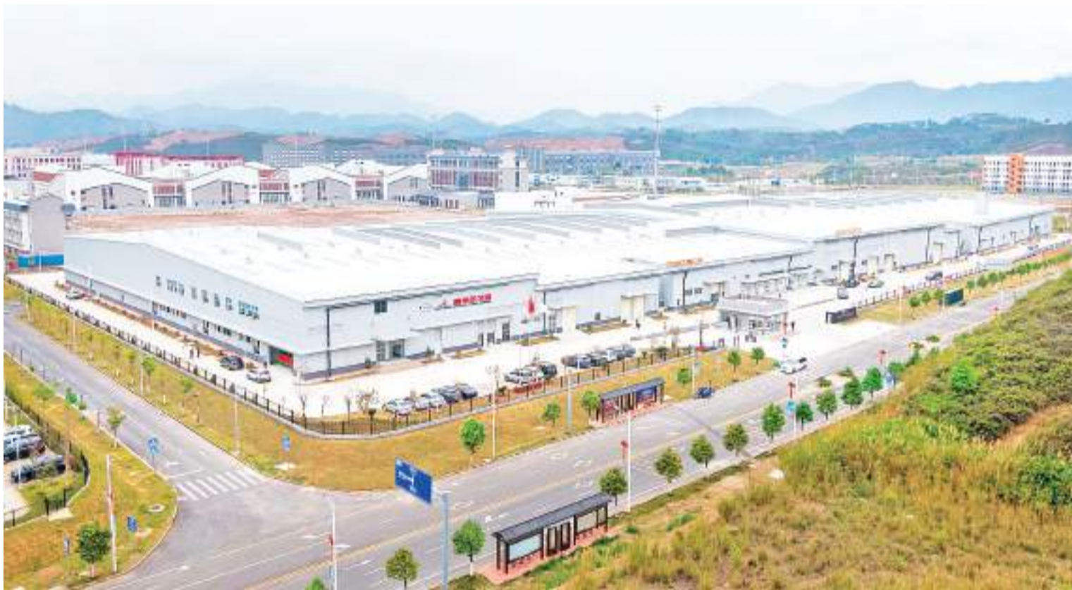
梅州圣戈班高端汽车玻璃生产项目。(连志城 摄)
