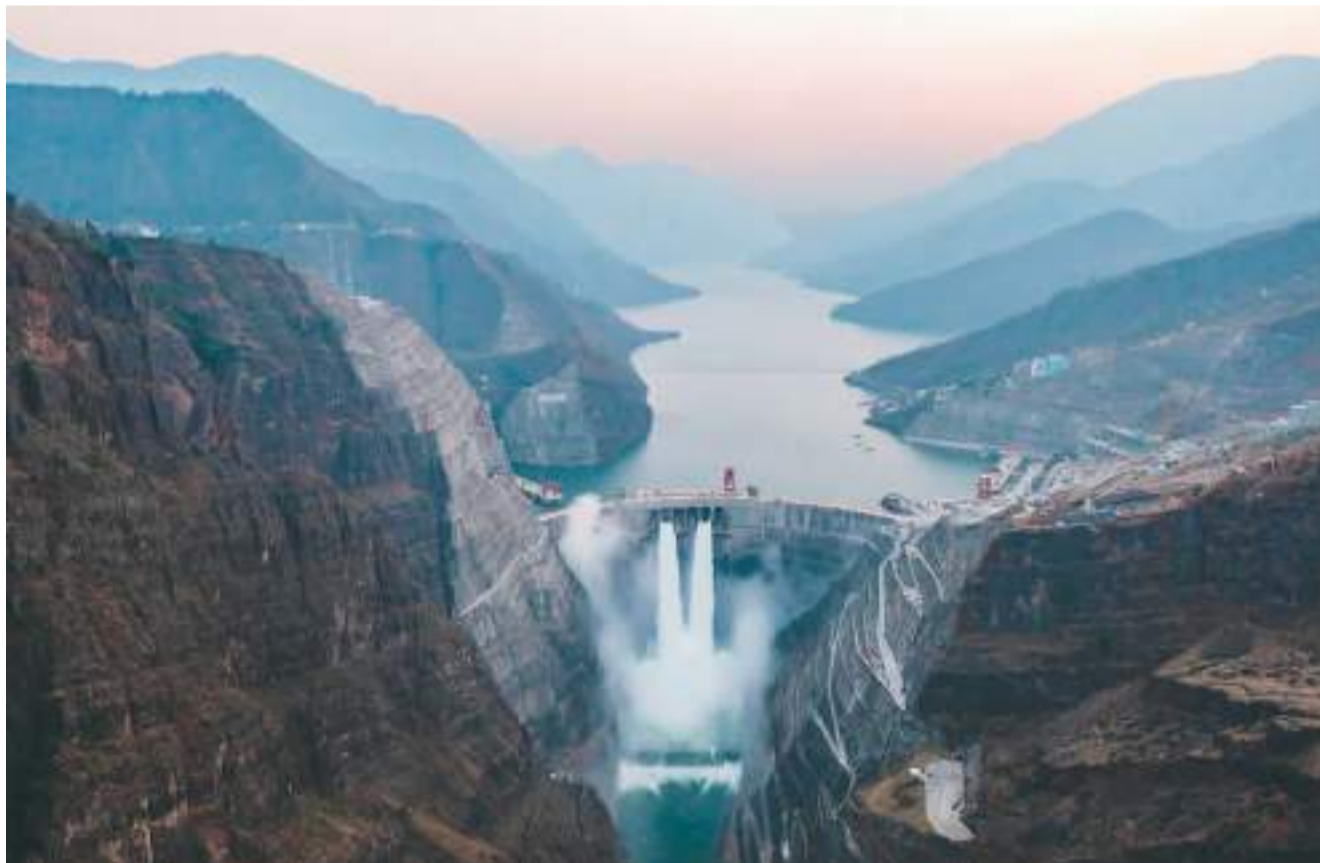
12月20日,金沙江白鹤滩水电站最后一台机组顺利完成72小时试运行,正式投产发电。至此,世界技术难度最高、单机容量最大、装机规模第二大水电站——白鹤滩水电站全部机组投产发电,标志着我国在长江之上全面建成世界最大“清洁能源走廊”。图为白鹤滩水电站风貌。 新华社记者 胡超摄
