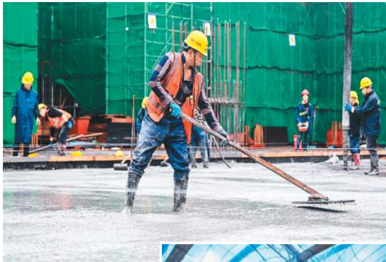
▲在南玉高铁控制性工程玉林北站施工工地，工人将浇筑的混凝土铺平，全力以赴赶工期。
