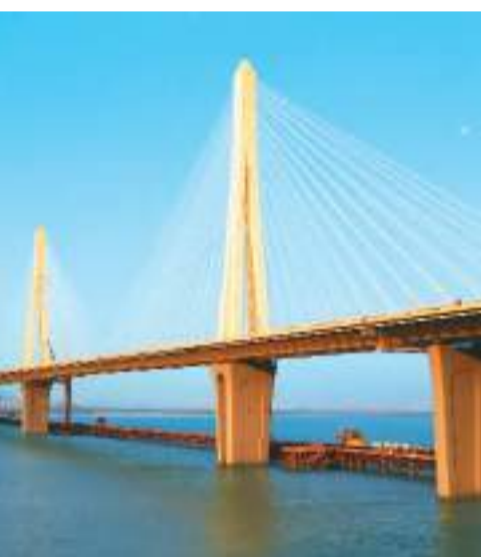
金海特大桥钢轨全部铺设完成
