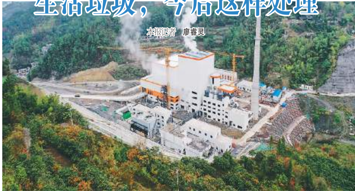
重庆市黔江区生活垃圾焚烧发电项目是武陵山区发电功率最大的生活垃圾焚烧发电项目，于今年3月开工建设，目前已实现与国网并网发电。图为该生活垃圾焚烧发电项目一角。
