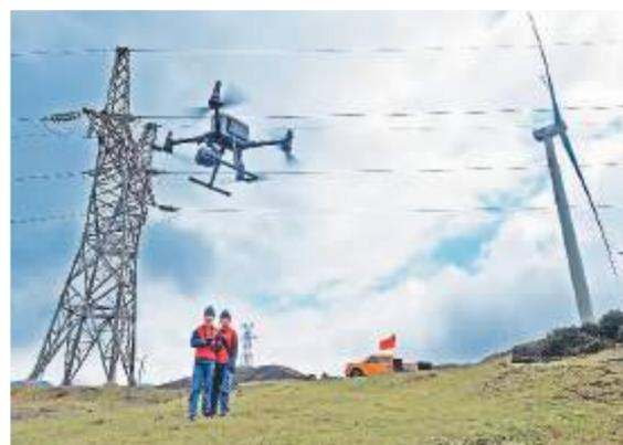
为保障今冬明春电网安全运行，南方电网贵州六盘水供电局近日安排工作人员前往六盘水市马寨镇，采取无人机自主巡检结合人工巡检的方式，对输电线路开展隐患排查。今年，六盘水供电局提前部署，对6套直流融冰装置、3套交流融冰变压器进行试验维护，确保今冬明春电网防冰工作有序推进。图为工作人员正利用无人机进行巡检。
