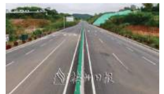
梅縣區東部快綫第五標段（雁洋環鎮路）已完成路面工程施工。（連志城 攝）
