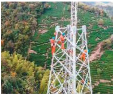
金山110千伏输电工程是浙江省湖州市长兴县“十四五”电力升级改造重点工程之一。新建配套输电线路将为当地旅游业发展注入优质电能,助力乡村振兴和共同富裕。图为国网长兴县供电公司电力员工正在协助相关人员进行铁塔立塔作业。谭云伟摄
