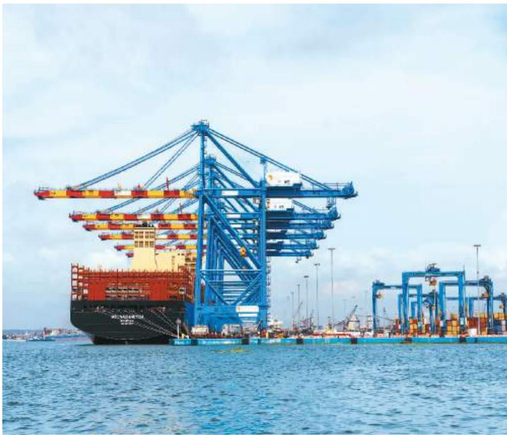
由中国港湾工程有限责任公司承建的科特迪瓦阿比让港第二集装箱码头日前正式开港。据了解，该码头自2015年启动建设，共有3个15万吨级码头泊位，岸线全长1312米，将使阿比让港年吞吐量从120万个提升至250万个标准集装箱。
