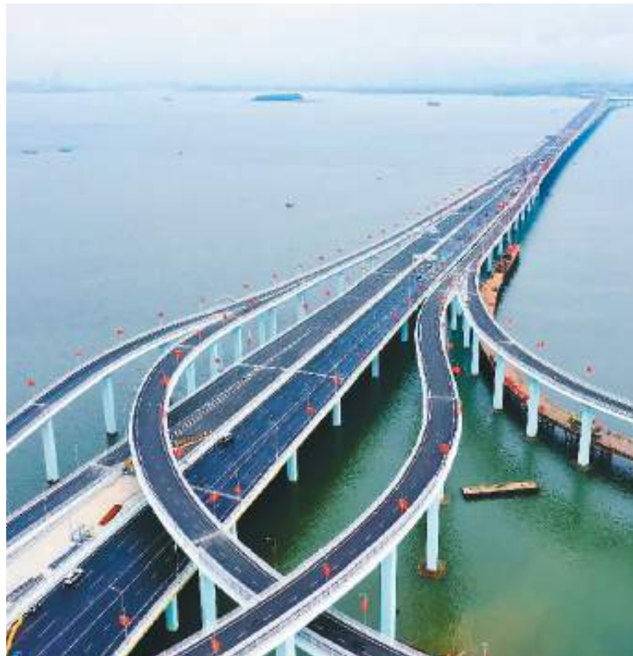
1月17日, 福建省首座预制装配化跨海大桥——厦门翔安大桥主桥正式通车。大桥全长约12公里, 其中跨海桥梁长约4.5公里, 设计时速80公里。图为俯瞰厦门翔安大桥。新华社发
